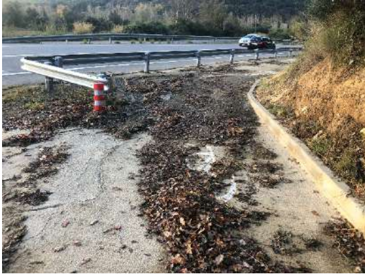
Foto 11. Neteja de cuneta al Carrilet I;
